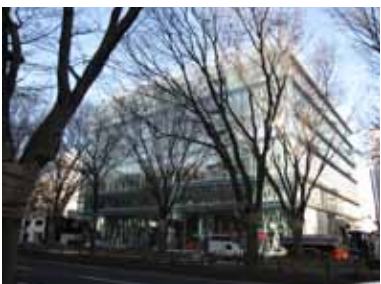
融入林蔭大道風景中的仙台媒體館，於二〇〇〇年底完工啟用。
